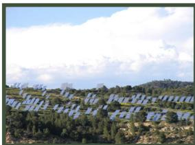
**Huerta Solar Fotovoltaica (Flix, España):** Dirección Facultativa y Ejecución en modalidad llaves en mano de un parque solar fotovoltaico de 12MW, el cual esta constituido por un sistema de solar trackers de doble eje con seguimiento astronómico y una segunda fase basada en generación a partir de concentración solar.
