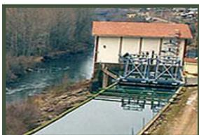
**Centrales hydroélectriques à León** : Conception, construction, exploitation et gestion de deux centrales hydroélectriques dans le bassin hydrographique du Douro : centrale « Orallo » et centrale « Altar », dont les puissances installées respectives sont de 300 kW et 758 kW.
