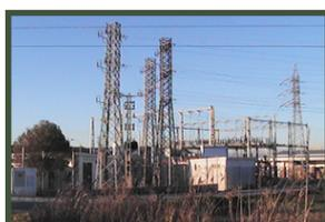
**Compagnie électrique La Prohida** : Services techniques de consulting pour le déploiement du réseau de transport et distribution électrique, avec un poste de transformation de 33 kV/10 kV de 15 MVA, 69 km de lignes à 10 kV, 98 transformateurs BT et un total de 77 km de réseau de distribution.
