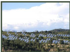
**Ferme solaire photovoltaïque Flix** : Direction technique et exécution selon une modalité clé en main d'un parc solaire photovoltaïque de 12 MW, constitué par un système de suiveurs astronomiques à deux axes, et une seconde phase de génération par concentration solaire.
