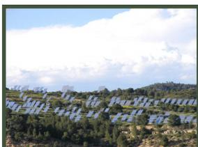
**Horta Solar Fotovoltaica Flix:** Direção Facultativa e Execução *Chave na Mão* de um parque solar fotovoltaico de 12MW, o qual é constituído por um sistema solar de trackers de duplo eixo com seguimento astronómico e por uma segunda fase baseada na geração a partir de concentração solar.
