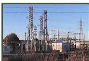
**Estação Elétrica La Prohida:** Serviços Técnicos de Consultoria na dispersão da rede de transporte e distribuição elétrica, contando com uma estação transformadora de 33kV/10kV de 15MVA de capacidade, 69 km de linhas de 10kV, 98 transformadores de BT e um total de 77 km de traçado de distribuição.
