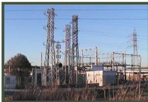
**Электростанция La Prohida (Кастилья-Леон, Испания):** техническое консультирование развёртывания электrorаспределительной сети, с учётом трансформаторной подстанции 33кВ/10кВ мощностью 15МВ·А, 69 км линий электропередачи 10кВ, 98 трансформаторов низкого напряжения и 77 км распределительных линий.
