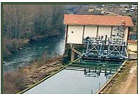
**Гидроэлектростанции в бассейне реки Дуэро (провинция Леон, Испания):** проектирование, строительство и эксплуатация двух гидроэлектростанций в бассейне реки Дуэро: «Оральо», мощностью 300 кВт, и «Альтар», мощностью 758 кВт.
