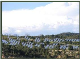
**Солнечная электростанция в муниципалитете Флиш, Испания:** исполнение «под ключ» проекта солнечной электростанции мощностью 12 МВт, в составе которой имеется система двухосевых солнечных трекеров с астрономическим отслеживанием положения солнца, а также вторая фаза генерации электроэнергии на основе концентрации солнечного излучения.
